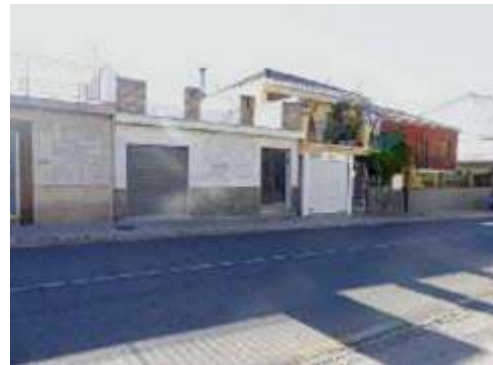
Ilustración 1. Medianera típica de la ciudad de Almería
